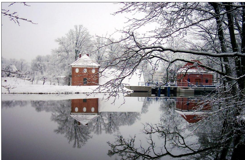
Fot. 1 – Elektrownia w Ołowniku zimą.
