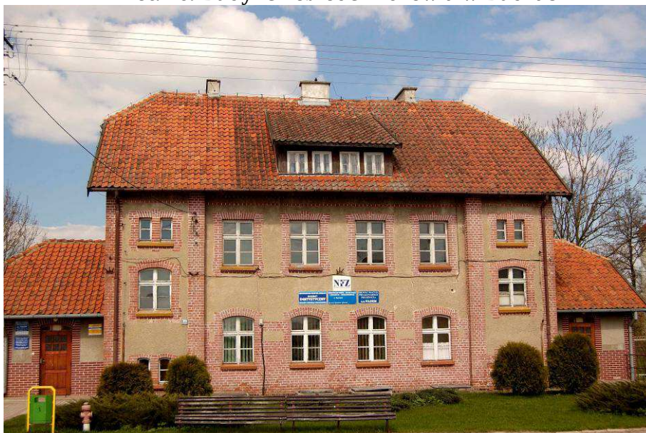
Fot. 26. Budynek ośrodek zdrowia w Budrach
