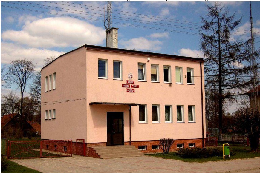
Fot. 25. Budynek Urzędu Gminy w Budrach
