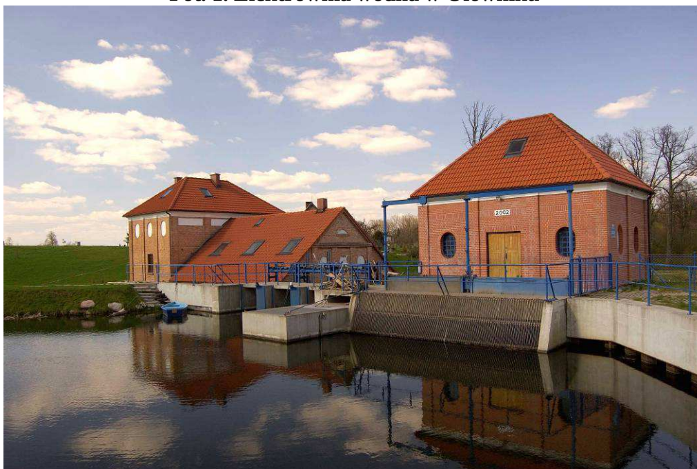
Fot. 1. Elektrownia wodna w Ołowniku
